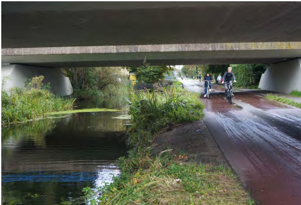
Het viaduct van de Afrikaweg boven de Voorweg. <FlexusAWC>
