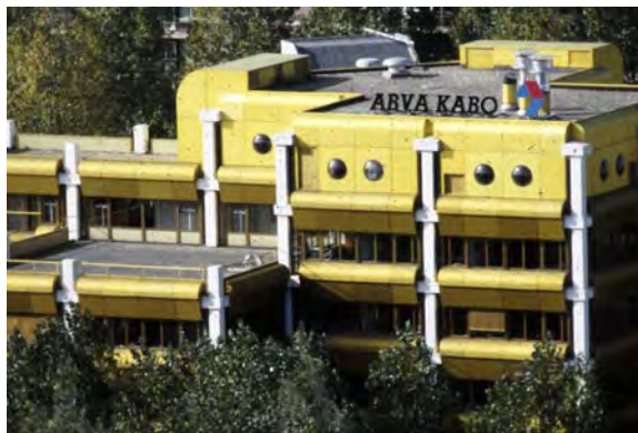
Oostgevel met installatieruimte en ronde vensters, 1980-90. <SAZ>
