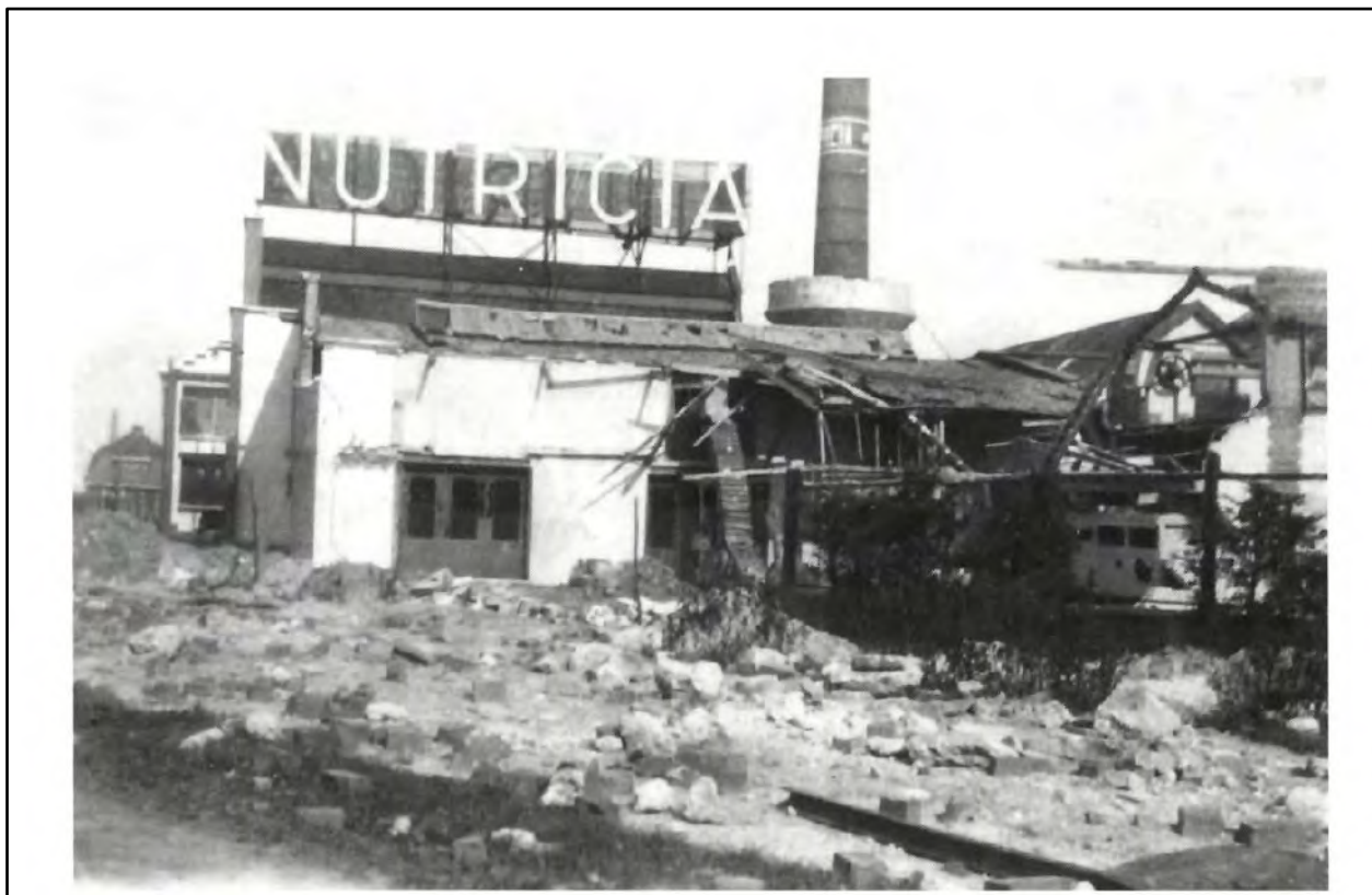
Figuur 25. Schade aan de Nutriciafabriek, 30 maart 1945. (Bron: Missing in Action , 13.)
