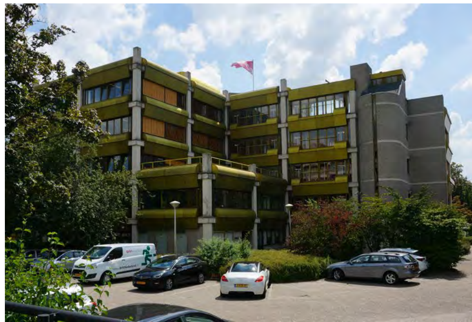
Noordwestgevel. <Flexus AWC>
