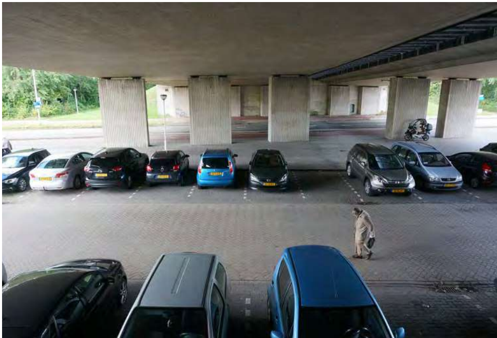
Onder het viaduct van de Afrikaweg. <FlexusAWC>
