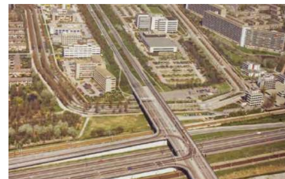
Het nieuwe viaduct van de Afrikaweg, de kantorenstroken en uiterst rechts het station. <SERC>
