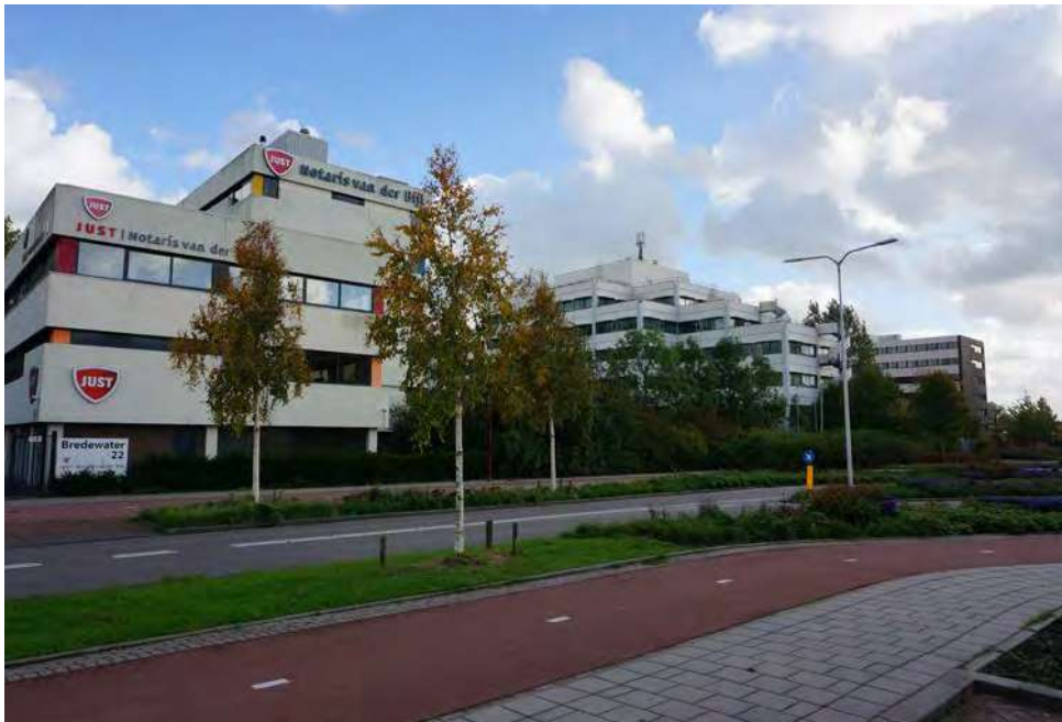
Deel van de kantorenstrook West. <FlexusAWC>
