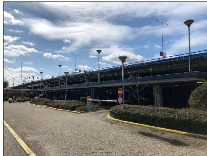
Figuur 3. Ter plaatse van de bovengrondse parkeerplaats bij de Afrikaweg zal in de toekomst een watergang worden gerealiseerd. (Locatiebezoek Saricon, 8 april 2021)
