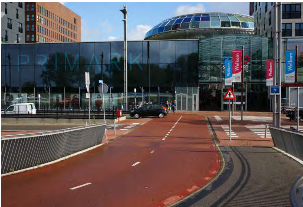
Einde fietsbrug met entree Stadshartpassage. <FlexusAWC>
