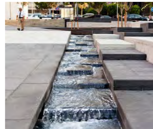
Watercascades maken afvoer hemelwater zichtbaar
