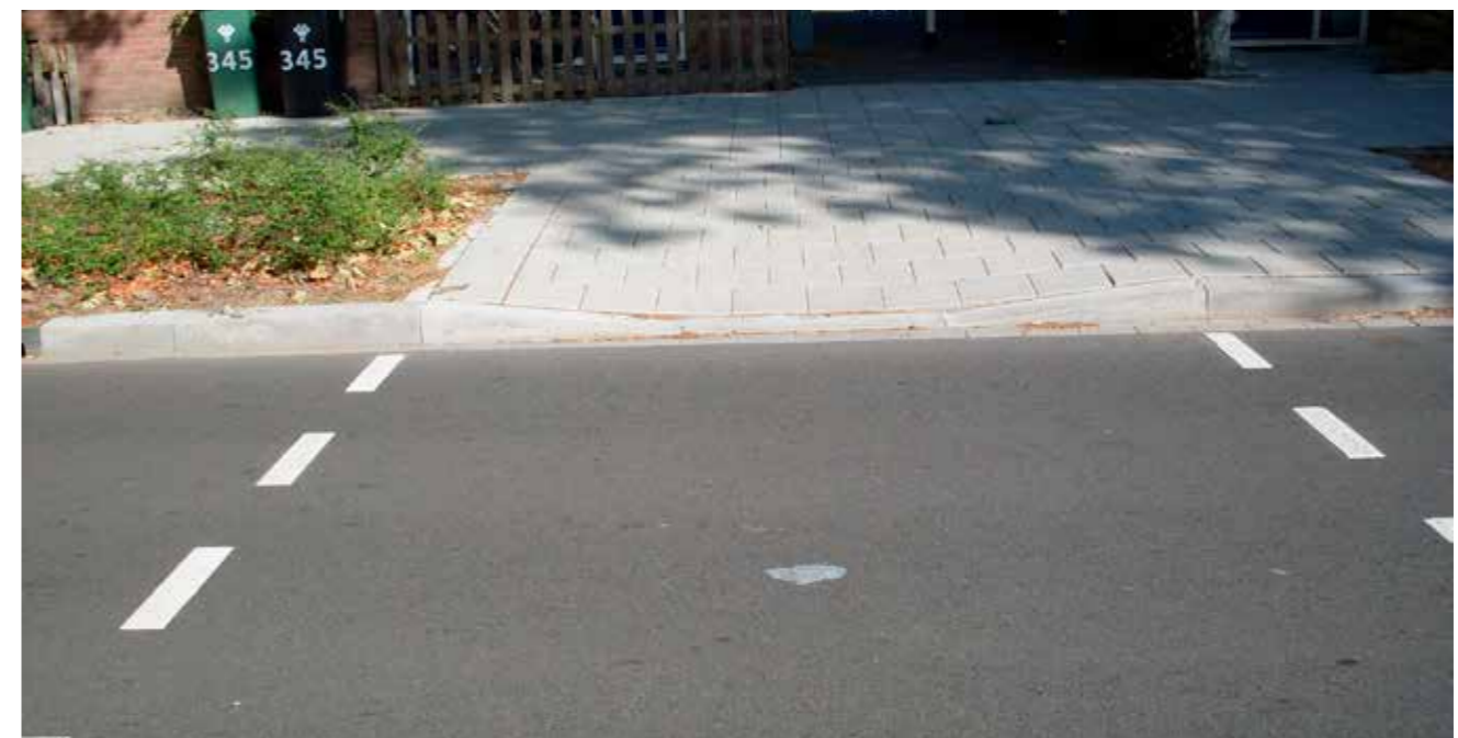
Verlaagde trottoirband met kanalisatiestrep
