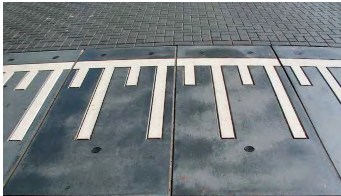
Drempel met taludmarkering
